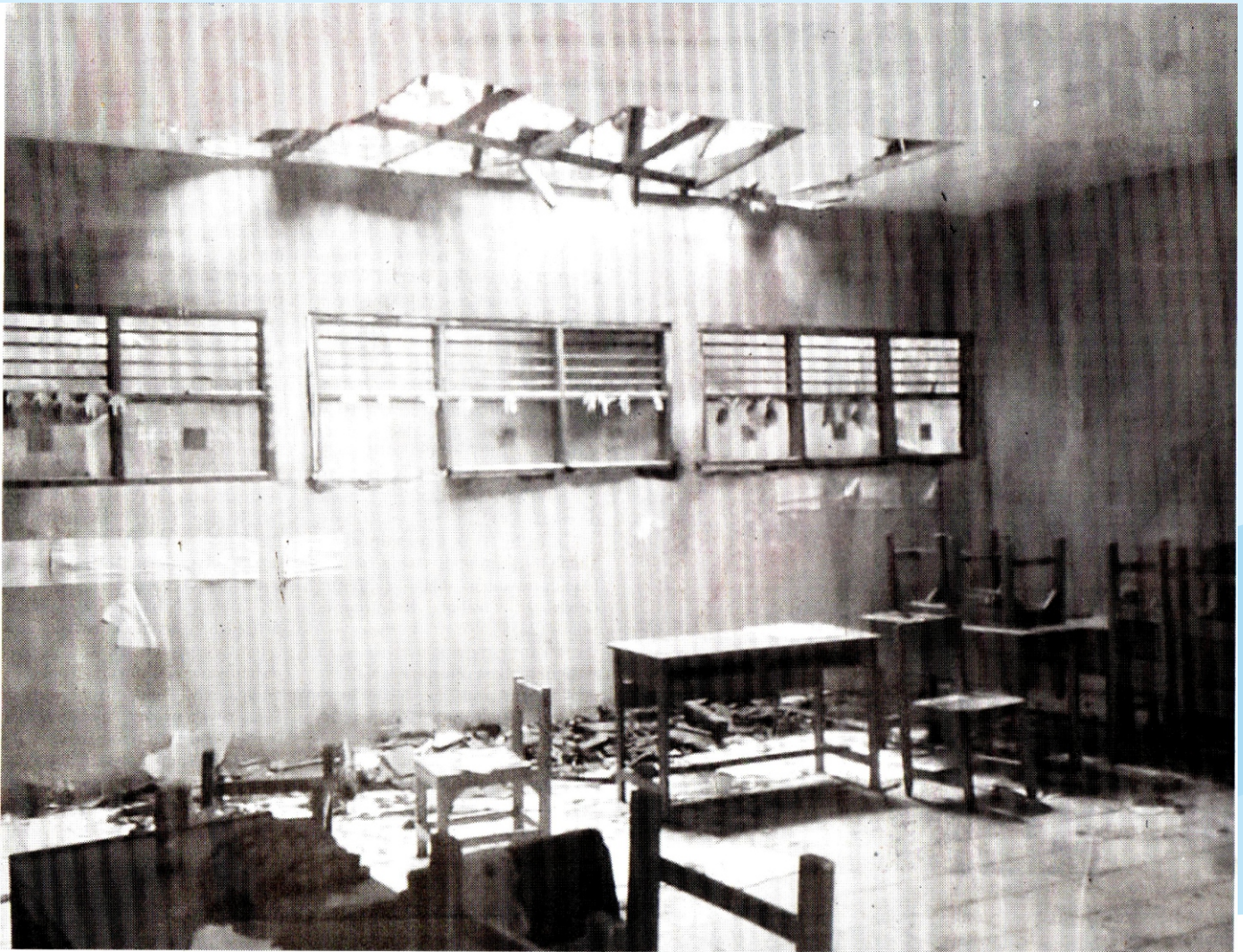
RUANG KELAS SDN LEBAHNGOK AMBRUK. Kondisi Atap Kelas yang Ambruk.
